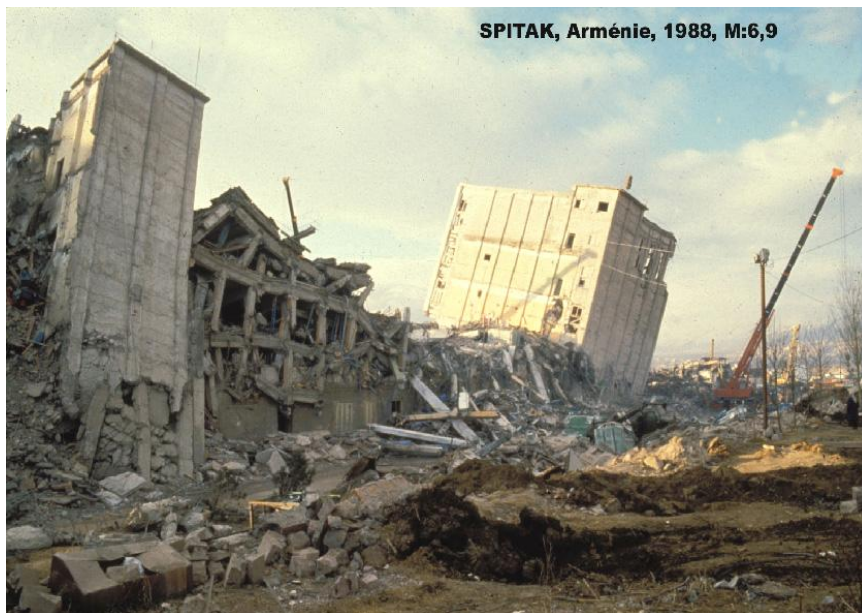
9 – Ejemplo de una construcción fuera de norma
